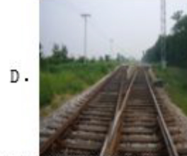
在铁轨下面铺枕木
